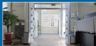
AIRMAX-Air curtain 출입구 양쪽에 설치하여 양방향으로 공기를 강하게 배출시켜 외부의 공기 흐름을 차단하여 유입되는 미세먼지 및 유해세균을 막아줌
