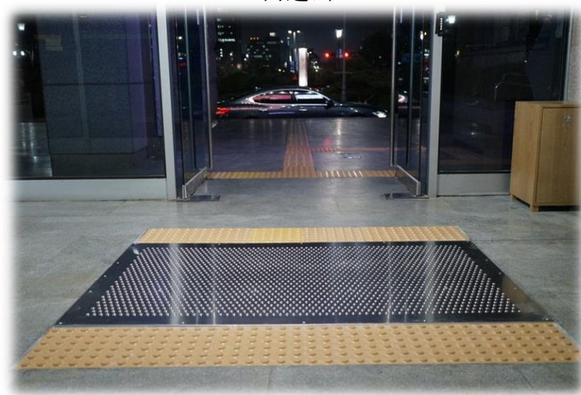
停车场进出口
