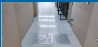
악세스 플로어용 (AIRMAX-AF) Access floor 구조의 장소에 설치되는 모델로, 바닥재를 떼고 그 자리에 AIRMAX-AF를 설치
