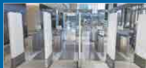
入口用 (AIRMAX-G) 人及叉车出入的入口之间安装的型号
